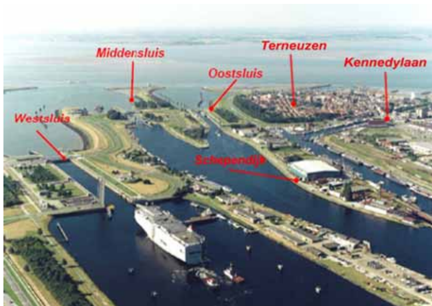
Figuur 2-2 Overzicht Sluizencomplex Terneuzen
