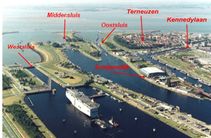
Figuur 2-2 Overzicht Sluisencomplex Terneuzen
